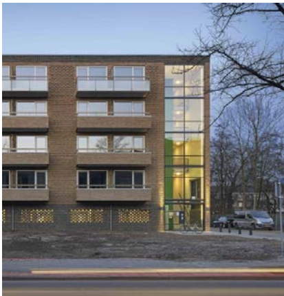
ZAAGMULDERSWEG base isolation
